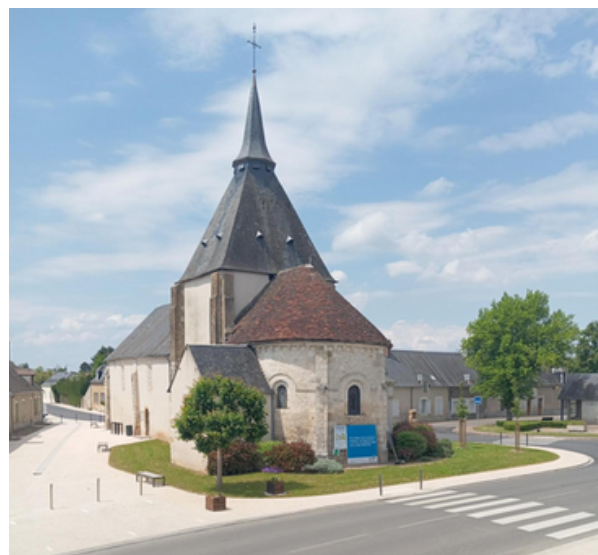
Aménagement de la place de l'église : végétalisation, piétonisation et revêtement clair. © Farges-en-Septaine
